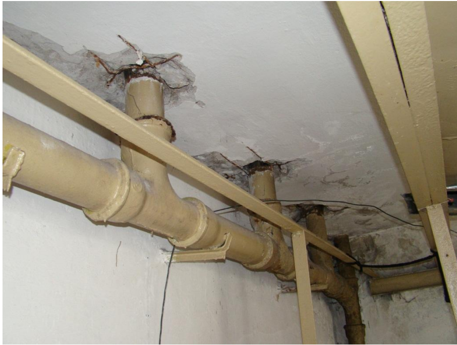
Cauruļu siltumizolācija un pagraba siltināšana.
