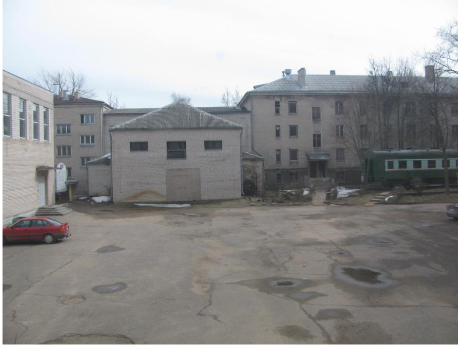
Dienesta viesnīcas Bauskas ielā 23 un 25 pirms renovācijas darbu uzsākšanas, skats no skolas iekšpagalma.
